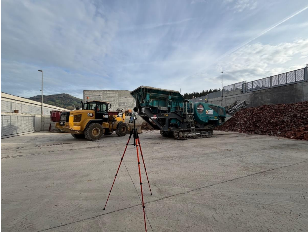
Nave y zona de ampliación
